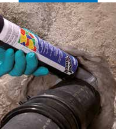
Applicering av Mapeproof Swell runt ett rör
