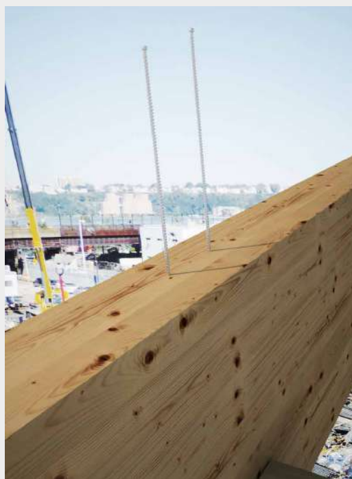
Ortogonal förstärkning i förhållande till fiberna för upphängd belastning på grund av förband med huvud-/sekundärbjälke.
