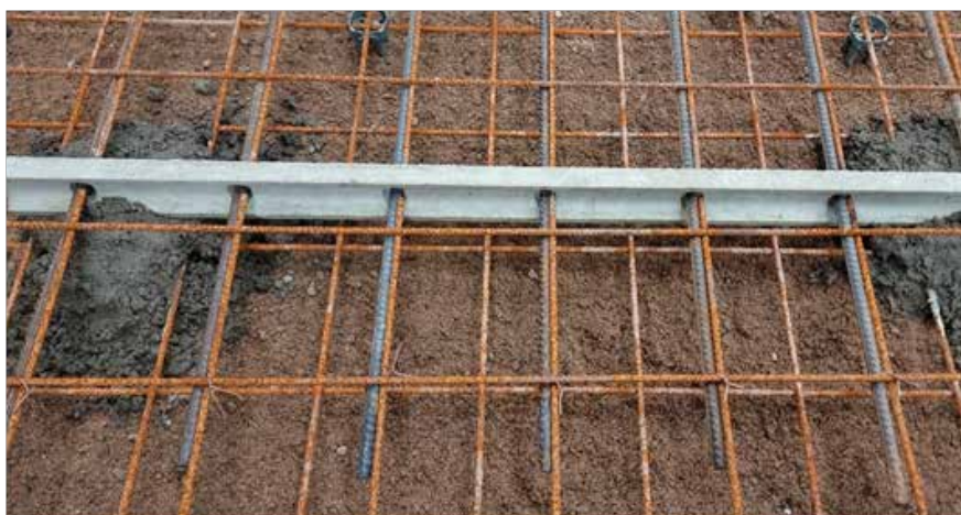
PERMABAN® som dubbelarmering
