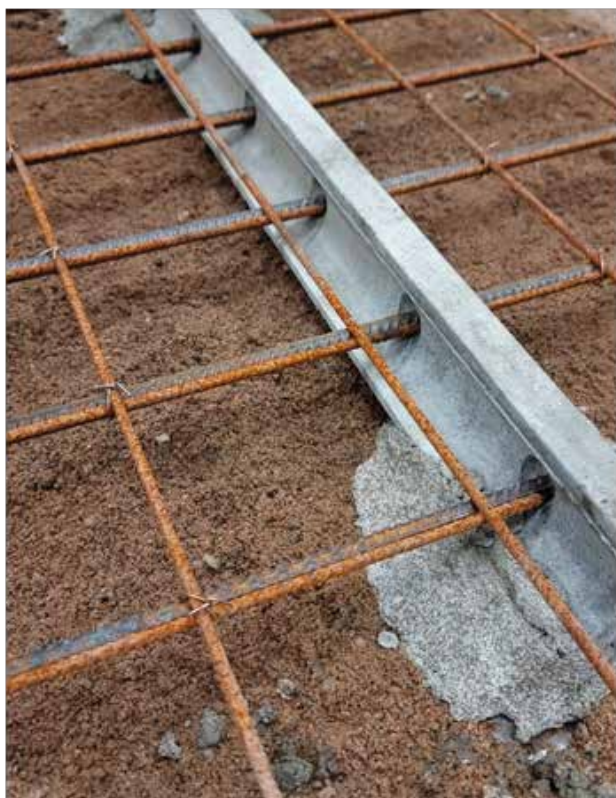
PERMABAN® som enkelarmering
